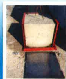
脱枠後 回収致します
