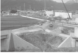
R477 吉沢高架橋
