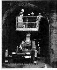
トンネルの点検▶
