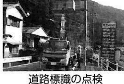
道路標識の点検
